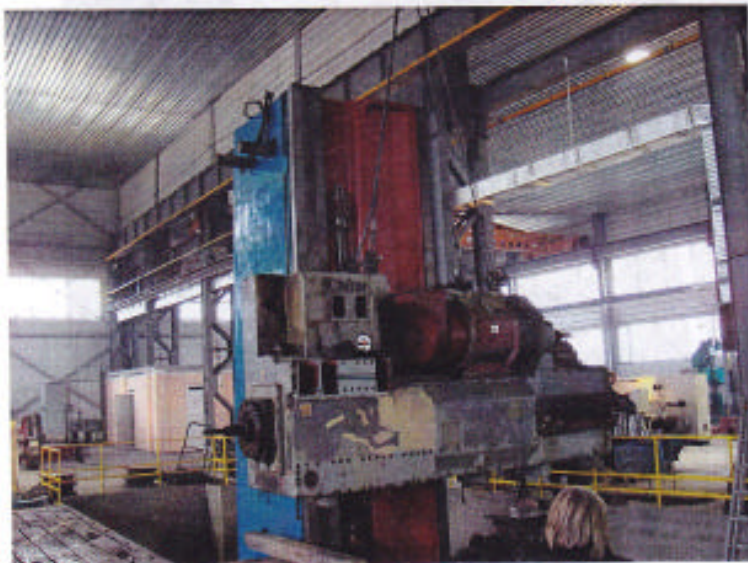
Рис. 3 – Расточная бабка установлена на станину и притянута к ней прижимными планками
