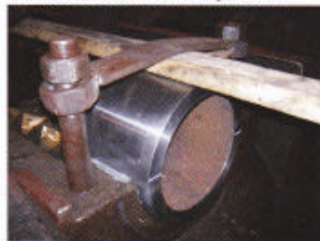
Рис. 4. Восстановление изношенной поверхности в корпусе с помощью шаблона.
