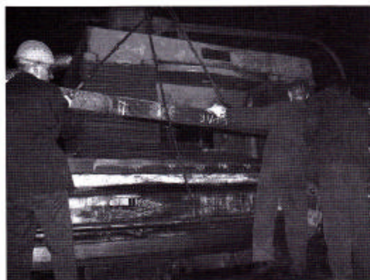
Рис. 7. Установка линейки на базовые поверхности
