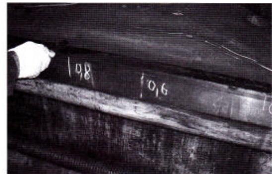
Рис. 5. Нанесение материала «Моглайс» на поперечину с помощью шпателя
